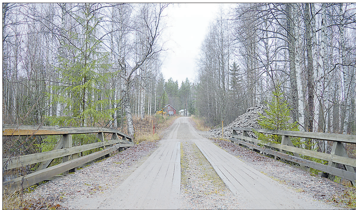
Kissakosken vanhan sillan kansirakenne alkaa olla jo melko pehmeä, siksi tiekunta katsoi parhaaksi uusia sillan.
